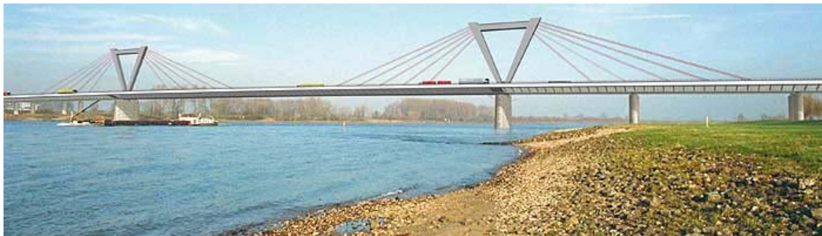
Bild 4: Flughafenbrücke Düsseldorf, A 44
