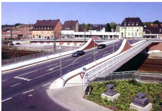
Bild 2: getrennter Querschnitt mit Pfeilerbetonung, Königsbrücke Löhne, L 773
