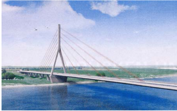
Bild 6: zukünftige Rheinbrücke Wesel, B 58
