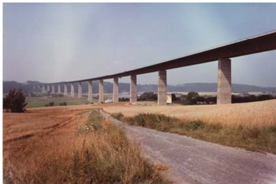
Bild 7: Ansicht Ruhrthalbrücke Mintard, A 52
