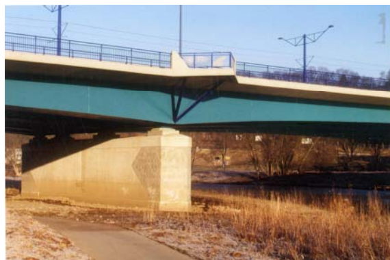
Bild 3: Pfeiler und Kanzel Ruhrbrücke Hattingen, B 51
